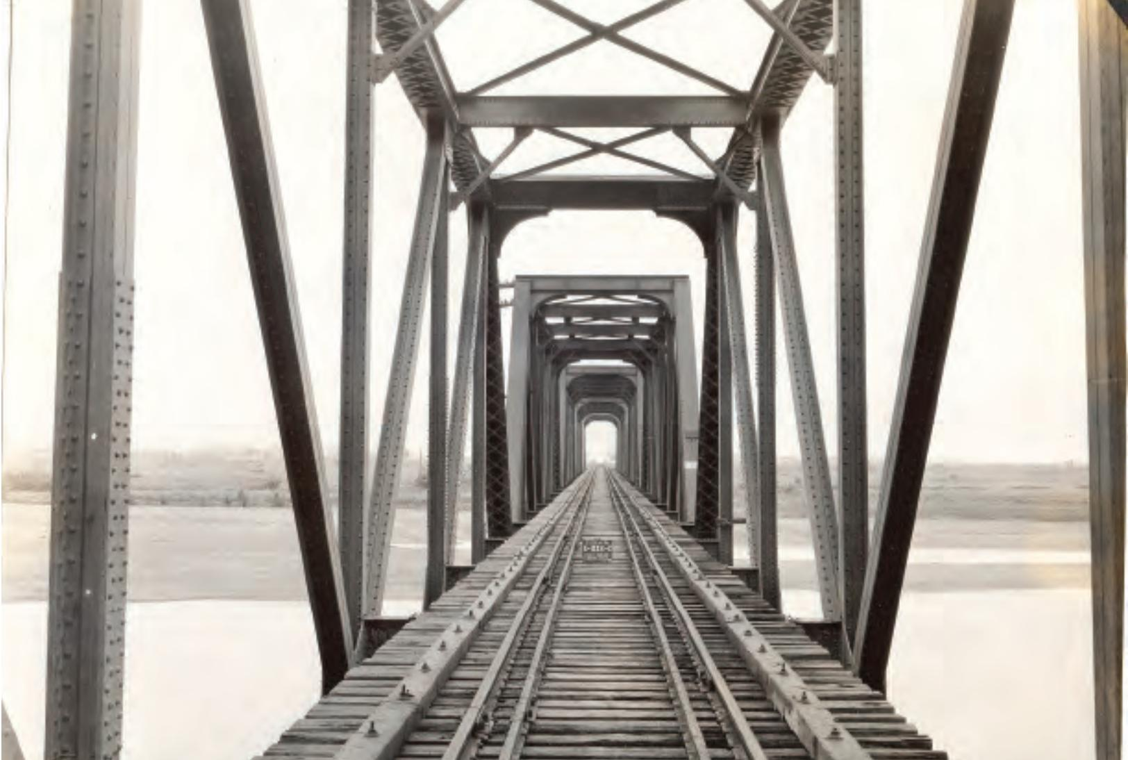
"Puente paso interior, tipo Pratt", longitud 235 metros, línea A-1138.
